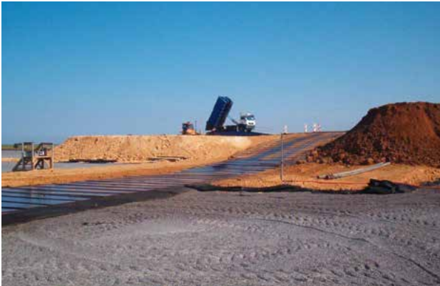
Trenn- und Bewehrungslage oberhalb des Deponiekörpers
