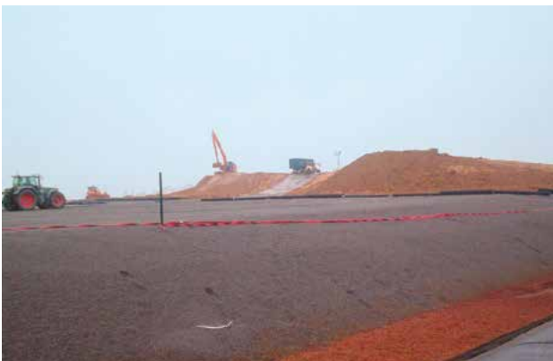
Aufbringen des Profilierungskörpers
