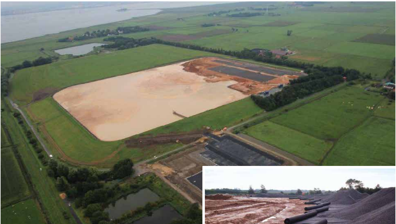
Luftbildaufnahme der Deponie
