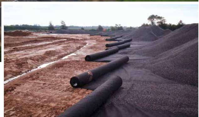
Geokunststoffbewehrung mit Bändchengewebe zwischen Jarosit und Profilierungskörper
