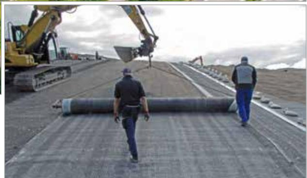
Einbau GTD mittels Bagger und Traverse
