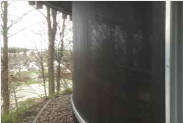
Montage in Rundung mit gewalzten Alu-Kederschienen
