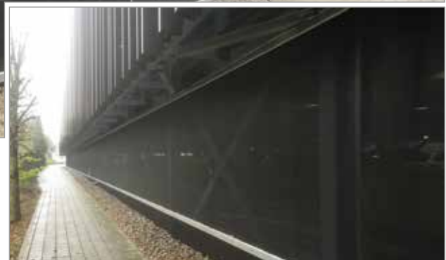
Fassadenverkleidung mit Tectura Spannvariante
