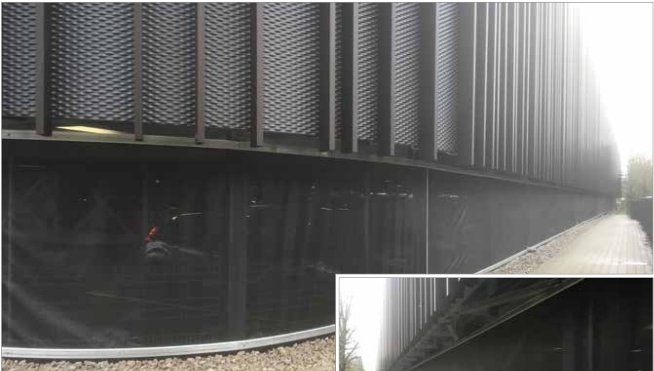
Parkhaus der Fa. ARBURG in Loßburg
