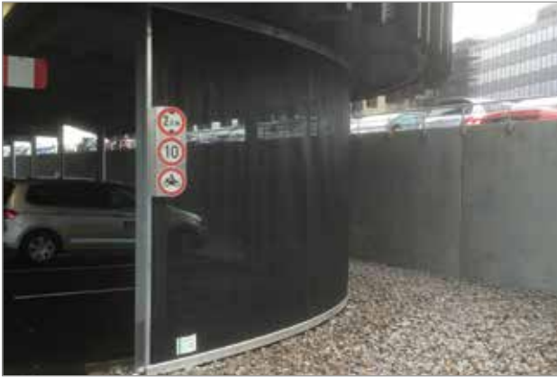
Anpassung an runde Gebäudeform durch flexibles Material
