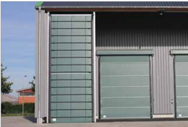
Tectura Faltfront mit 8 m Höhe und 3 m Breite
