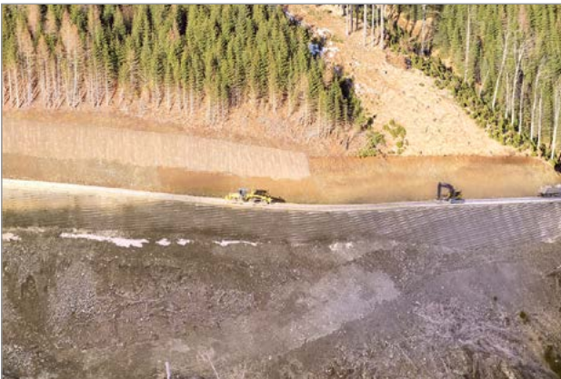
Fertiggestellte Begleitstraße auf dem kunststoffbewehrten Damm an der westlichen Talflanke
