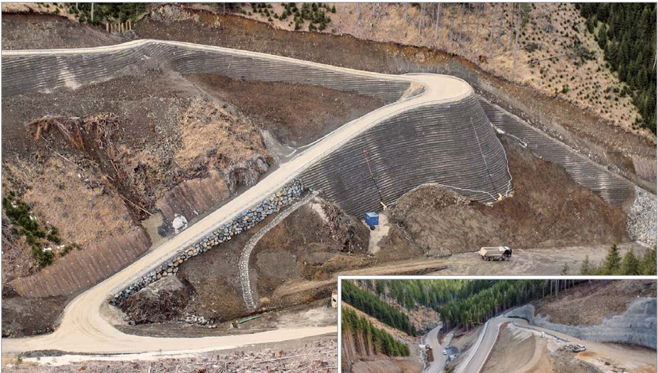
Kehre der Begleitstraße auf einem 25 m hohen kunststoffbewehrten Damm
