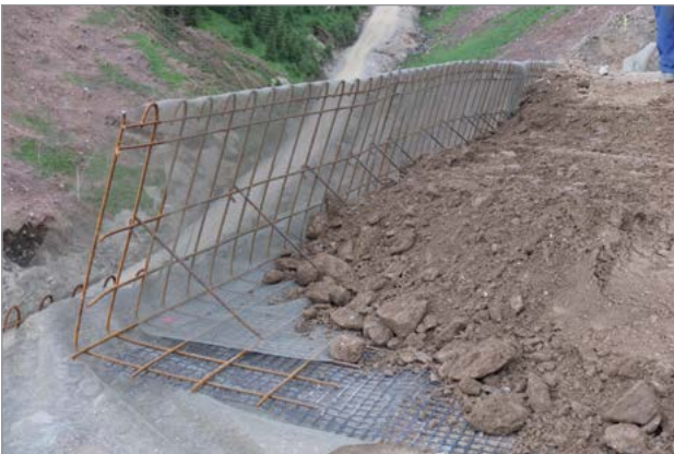
Fortrac Geogitter als horizontale Bewehrungslage; verlorene Stahl-schalung im Frontbereich mit innenliegendem Erosionsschutzgitter und Füllboden
