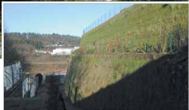
gebogene Baustahlgitter verwendet. Zwischen der Stahlgitterfront und der Betonwand wurde ein Spalt von 20 cm belassen, der mit Mineralwolle verfüllt wurde.
