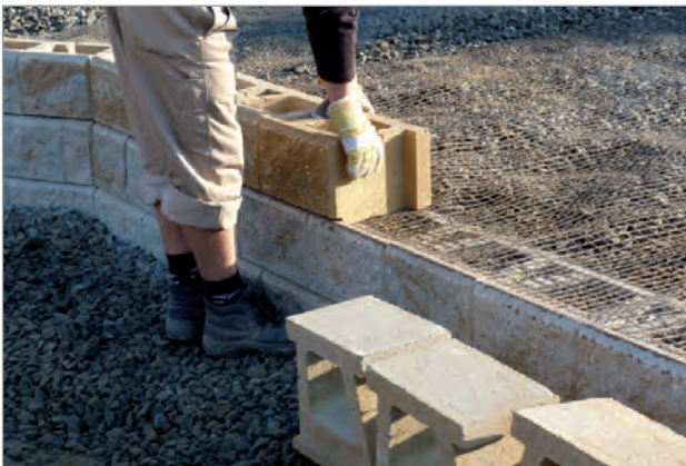
Einbau der Geokunststoffbewehrung
