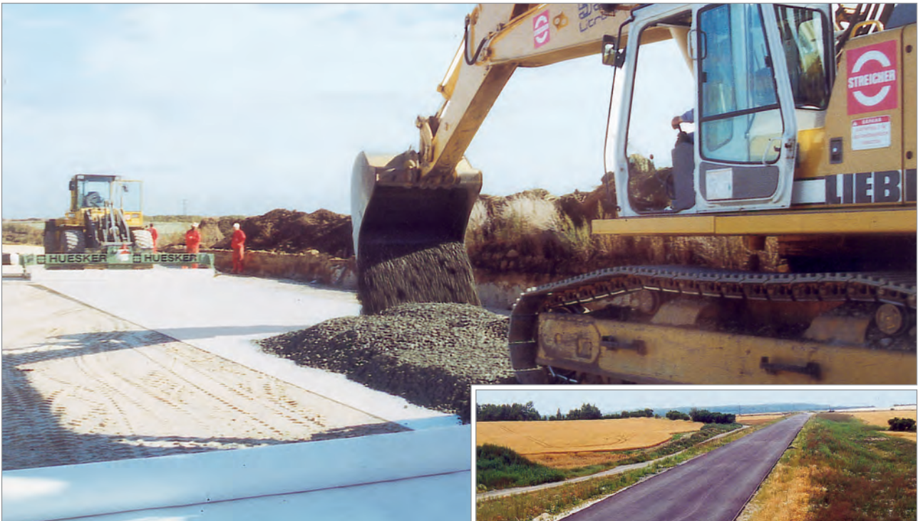
Einbau des Schotters „vor Kopf“ auf das vorgespannte Stabilenka® 1.000/100
