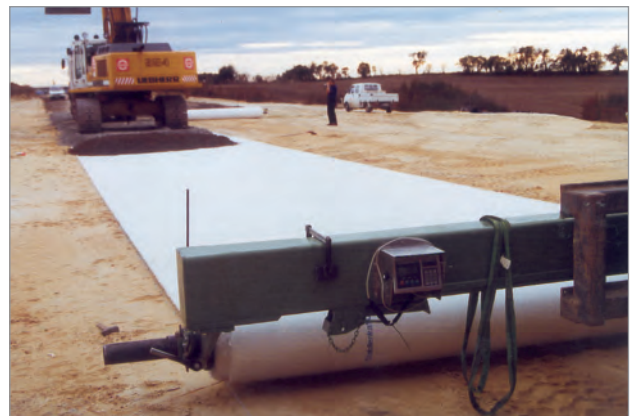
Selbst entwickeltes Spezialgerät der Firma HUESKER Synthetic für die Verlegung und Vorspannung von Stabilenka® 1000/100
