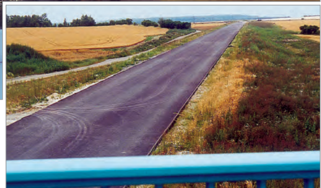
Ortsumfahrung Zeitz-Theißen nach Fertigstellung
