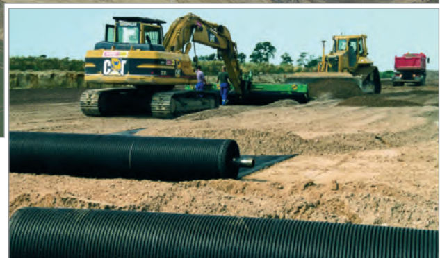
Verlegung des Geogitters Fortrac®
