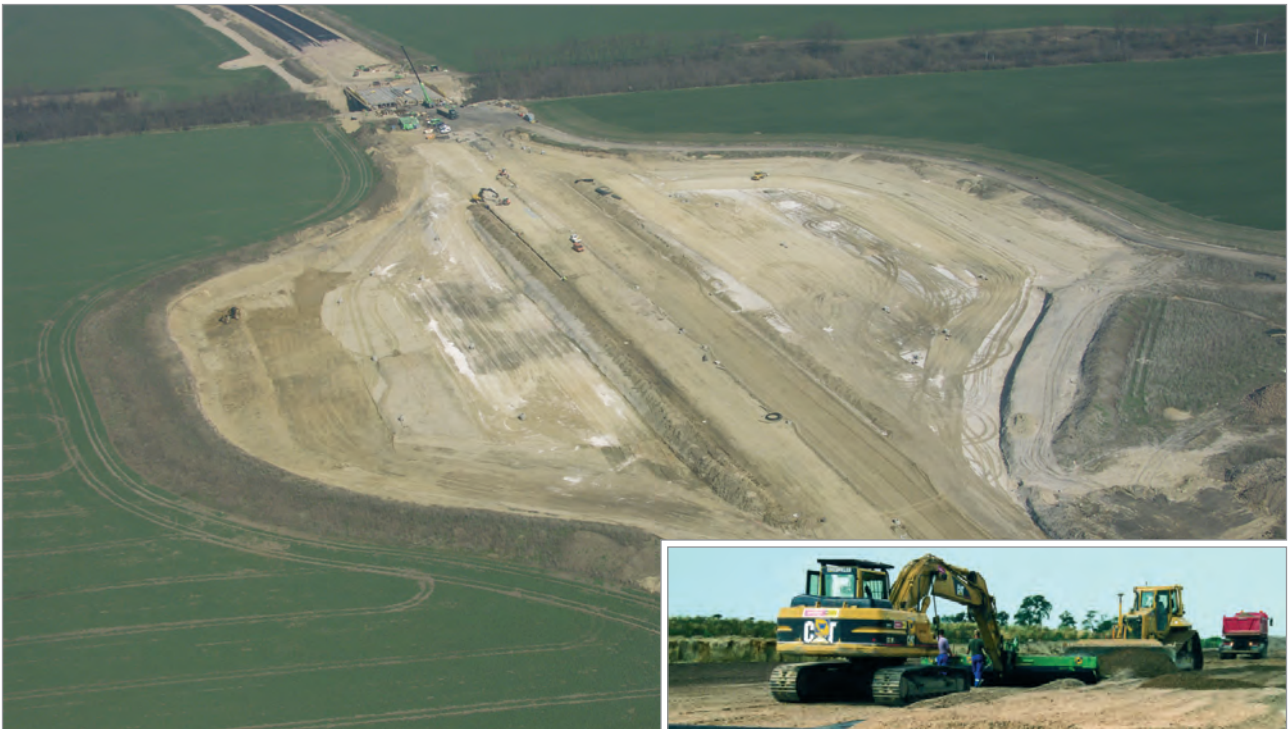
Luftbildaufnahme: A 143, Westumfahrung Halle, Raststätte
