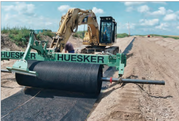
Verlegung mit spezieller Vorspanneinrichtung Hier: Halbe Rollenbreite im Randbereich
