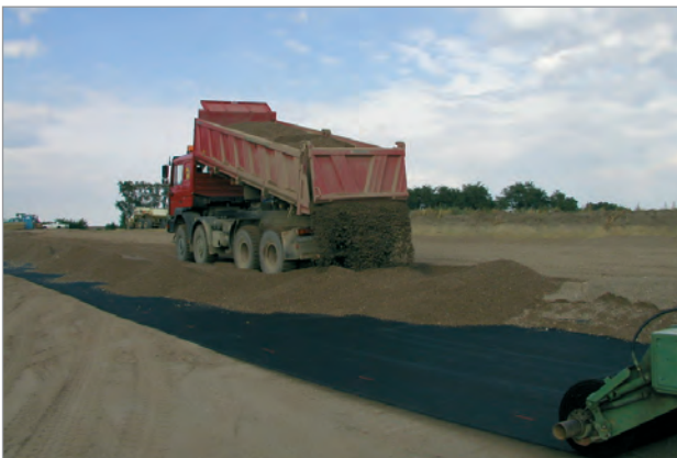
Überschüttung der Geogitterbahnen
