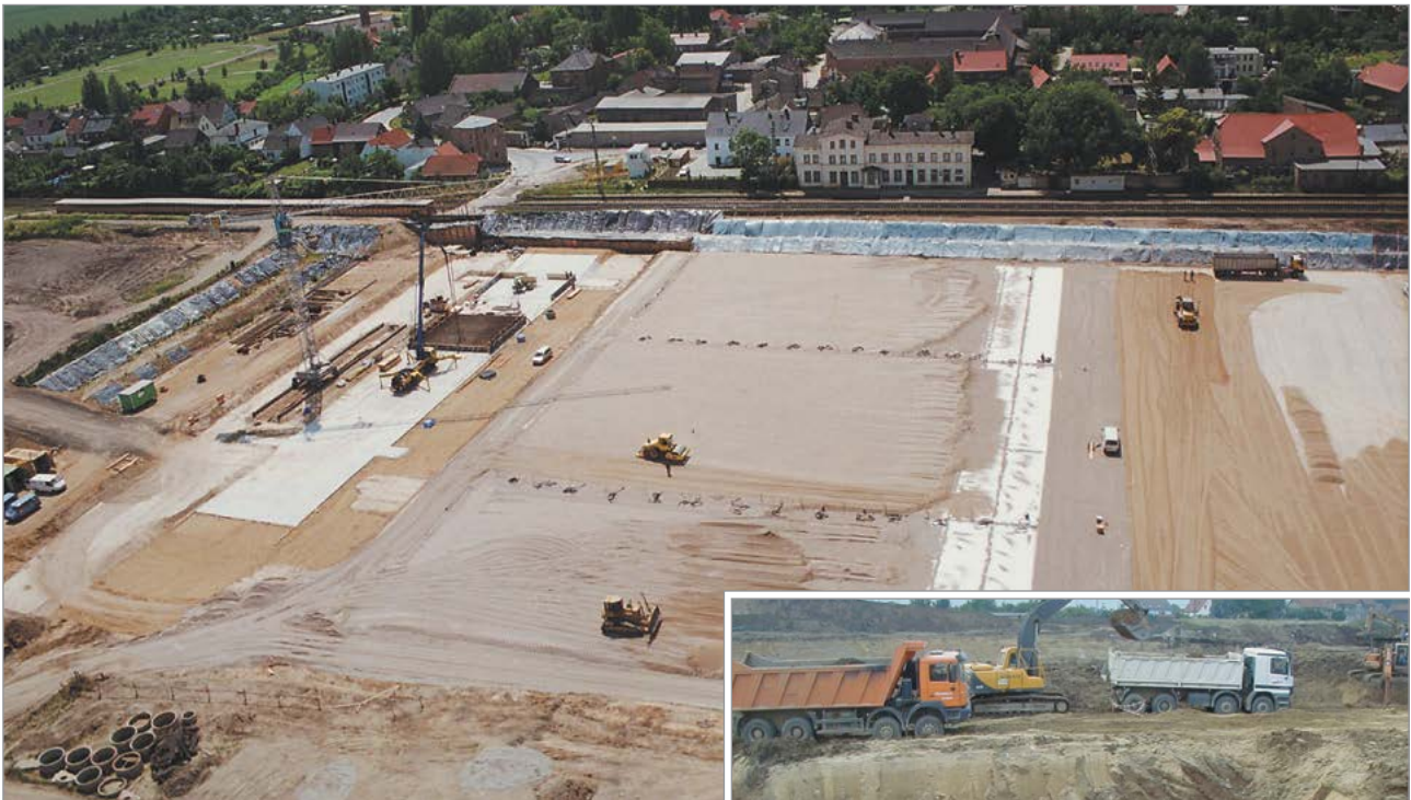
Knoten Gröbers, Luftaufnahme 2001
