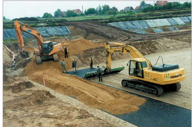
Einbau des Geogitters Fortrac R 1200/100-10 AM
