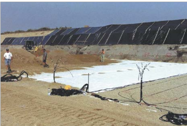
Einbau der Warnanlage
