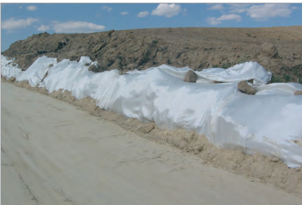
Rückumschlag des Bewehrungsgewebes am Böschungsfuß
