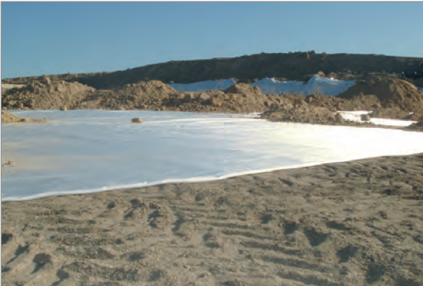
Verlegtes Stabilenka® Bewehrungsgewebe
