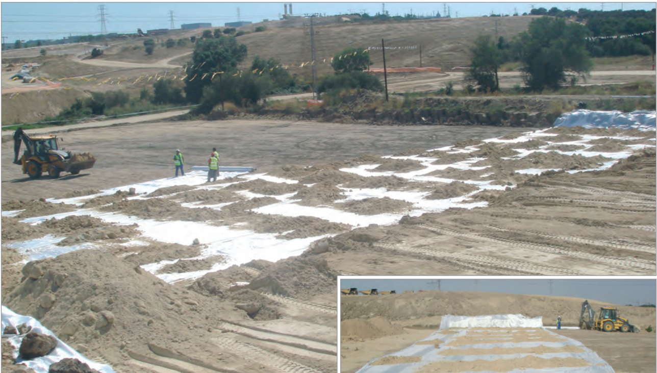
Übersicht der Baumaßnahme
