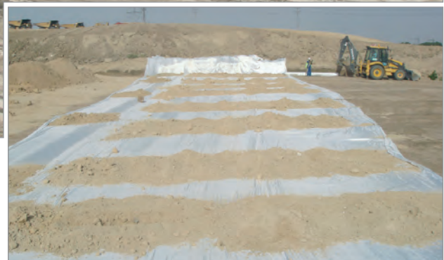
Verlegtes Stabilenka® - Bewehrungsgewebe
