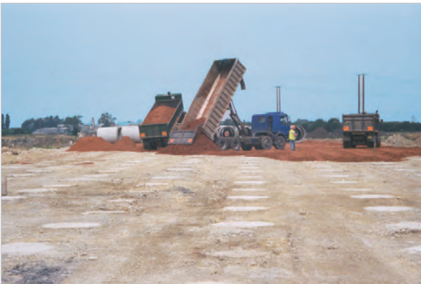
Vorbereitung der Ausgleichsschicht über Pfahlköpfen
