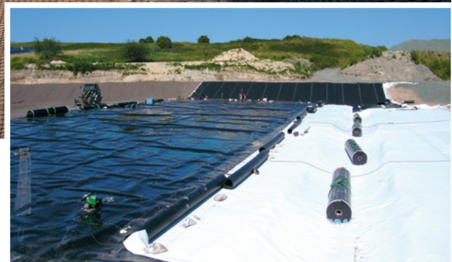
Schutzvliesverlegung
