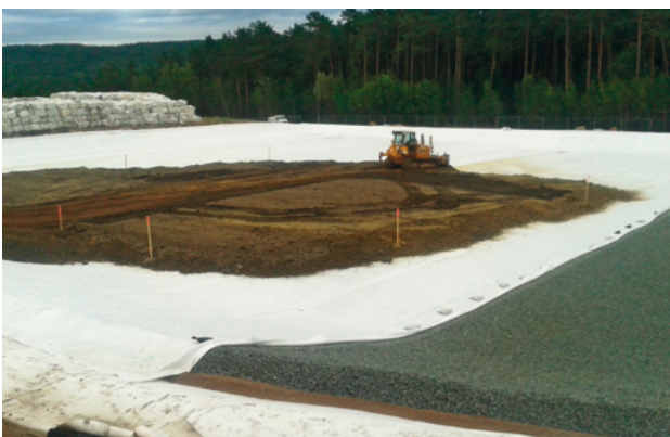
Einbau der Frostschuttschicht auf Trennvlies
