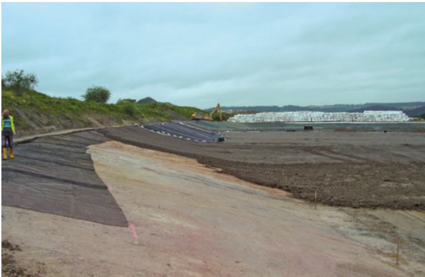
Geogitterüberdeckung Übergang zur Altdeponie
