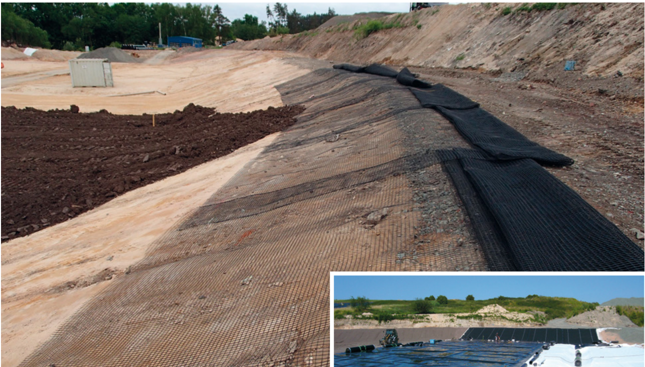
Geogitterverlegung mit rückgeschlagenem Teil
