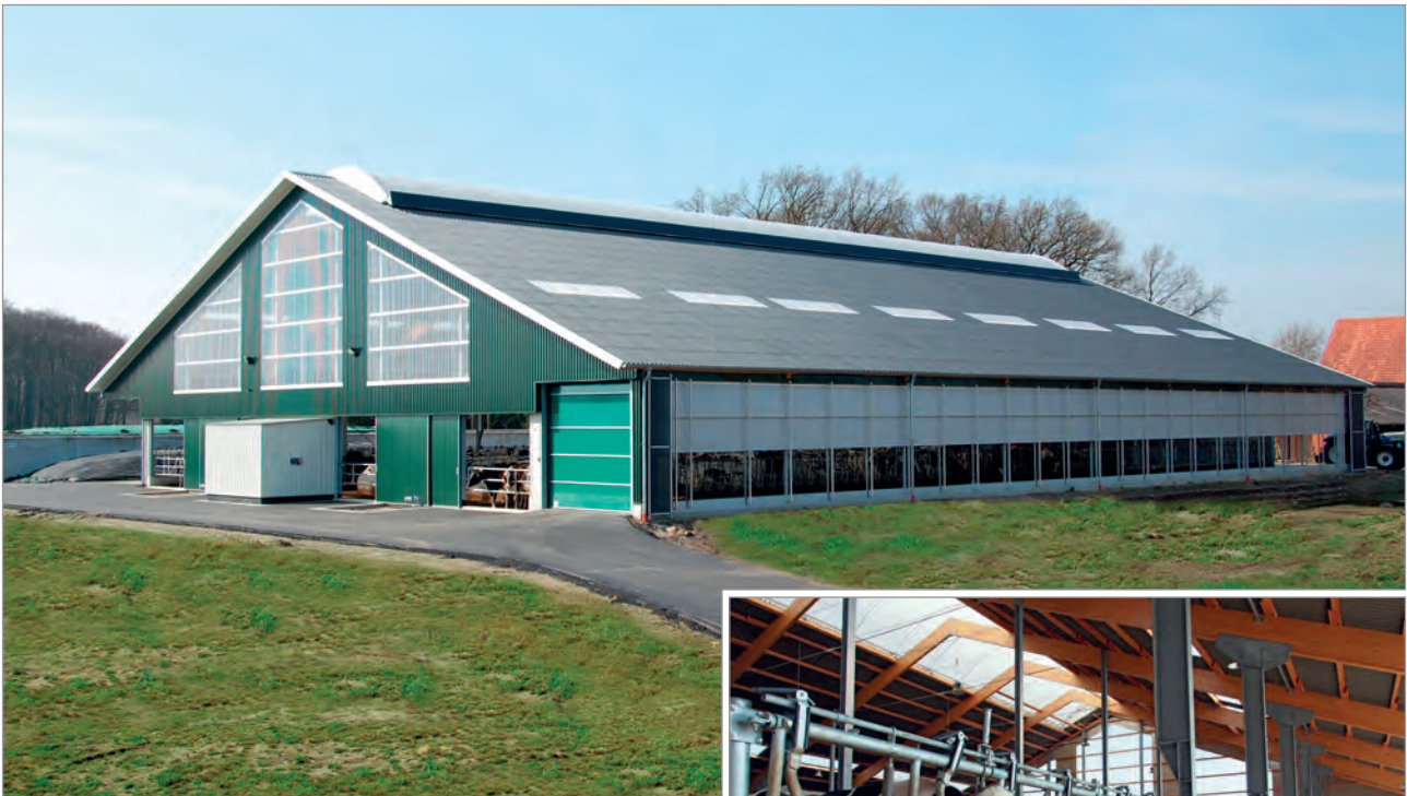
Außenansicht des Boxenlaufstalls mit allen drei verbauten Produkten
