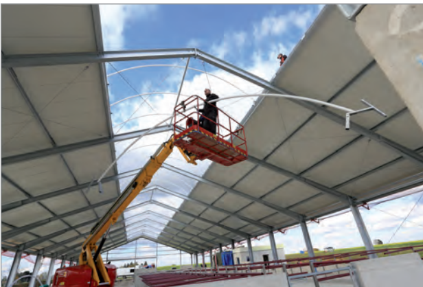
Montage der Bügel an der Dachkonstruktion
