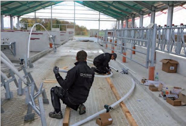
Vormontage der Bügel am Boden
