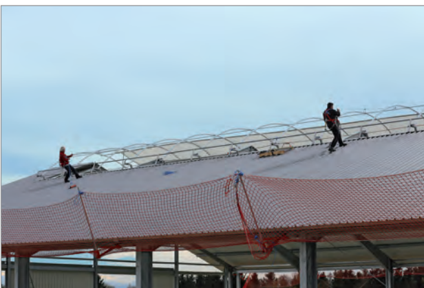
Plane über die Konstruktion ziehen
