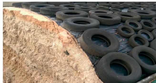
Herkömmliche Siloabdeckung mit hohem Arbeitsaufwand
