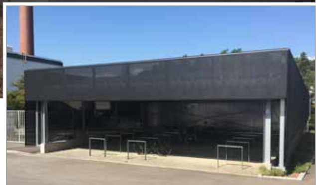
Fahrradunterstellplatz mit Tectura Fassadenverkleidung
