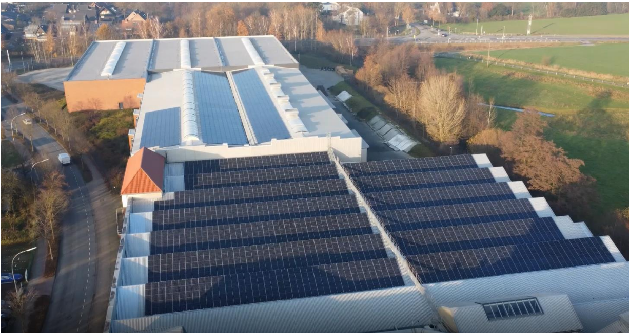
Bild 1: Luftaufnahme der Photovoltaikanlage auf dem Produktionsgebäude in Gescher
