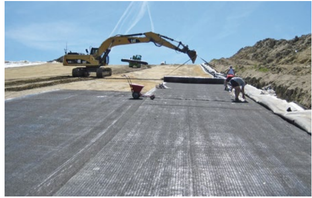
Oberflächenabdichtungen von Deponien
