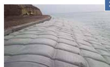
Befüllung der Panels mit fließfähigem Beton/Mörtel
