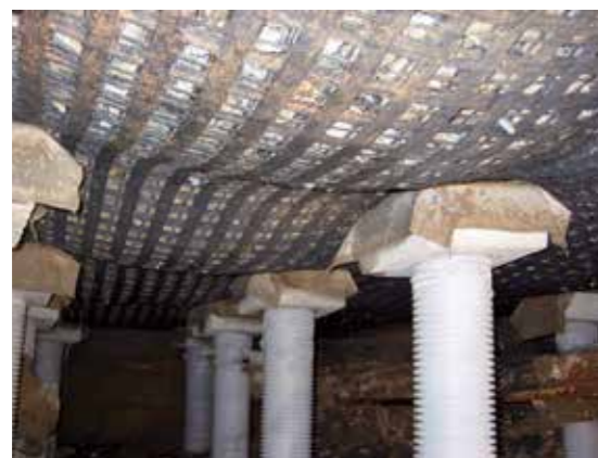
Membranwirkung bei aufgeständerten Polstern (Railway Bidor-Rawang, Malaysia)
