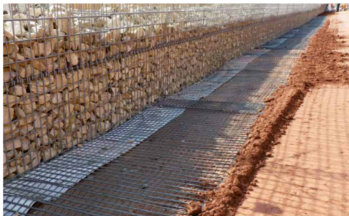
Rückverankerte Gabionenwand (A3 Höhe Haseltal, Deutschland)
