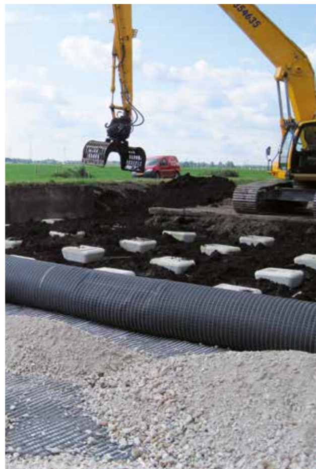
Verlegung der Geokunststoffbewehrung auf vertikalen Traggliedern (Autobahn N 210, Niederlande)
