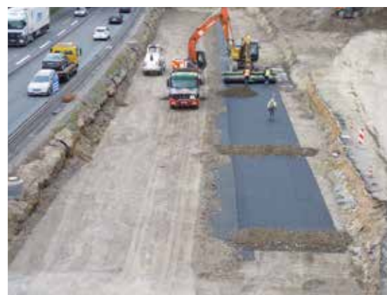
Verlegung einer Erdfallsicherung (Bochumer Westkreuz (A 52), Deutschland)
