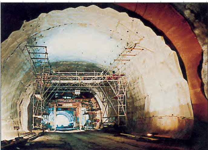
Hohe Flexibilität, verbunden mit hervorragenden mechanischen Eigenschaften, bestimmt primär die Qualität von HaTe® Vliesstoffen für den Tunnelbau. Aufgrund spezieller Fasermischungen werden die Bedingungen nach DIN 4102 (Brandverhalten) erfüllt.
