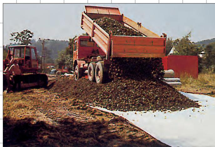
▷ **HaTe®** Vliesstoffe als Trenn- und Sauberkeitsschicht verringern den Bedarf an Schüttmaterial, erhöhen die Tragfähigkeit des Untergrundes und lassen sich leicht und schnell verlegen.
