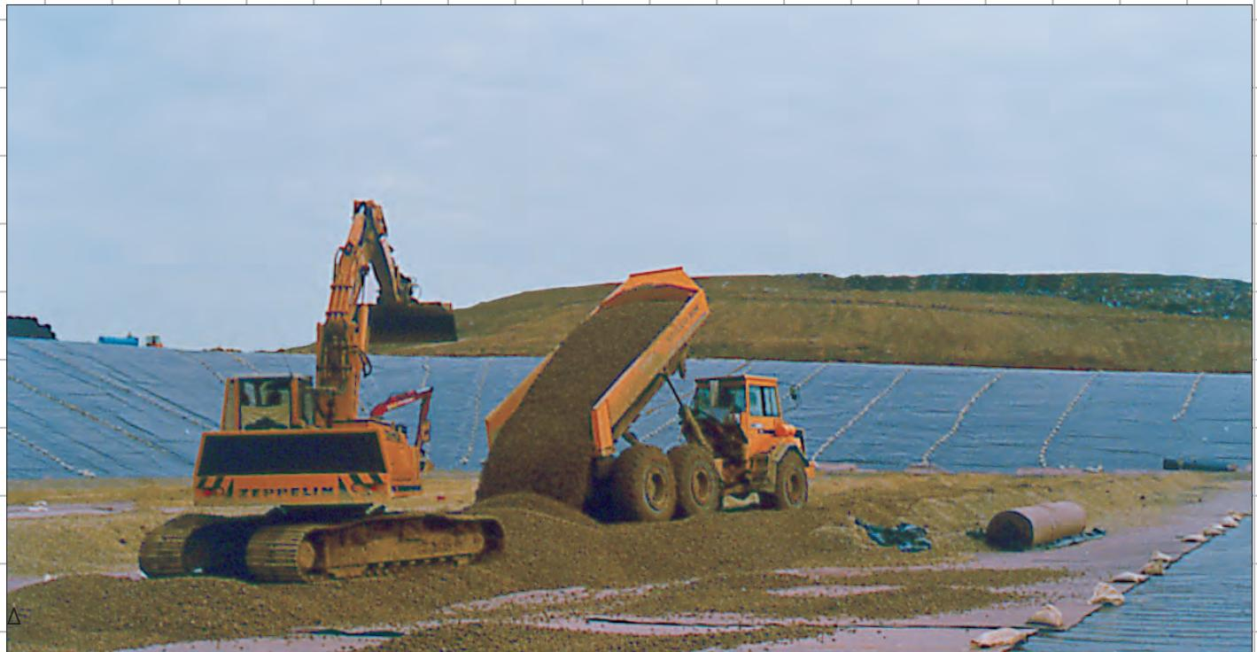
**HaTe®** Vlies- und -Strukturmatte bieten in der Deponietechnik den Dichtungsbahnen nicht nur ausreichenden mechanischen Schutz, sondern übernehmen je nach Erfordernis weitere Aufgaben, u. a. Dränen, Entgasen und Trennen.
