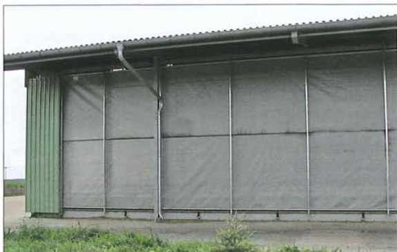
Некоторые варианты положения штор Фото 1: Проем в стене может быть практически полностью закрыт.
