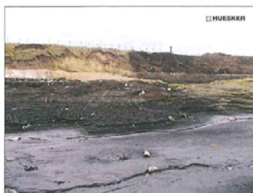
Im südlichen Bereich der Grube „Hoffnung“ reichten bereits Lasten außerhalb der Grube, um einen Grundbruch zu erzeugen.
