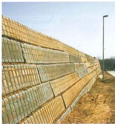
Lärmschutzbau: Bewehrte Böschung mit Gabionen als Frontelemente.
