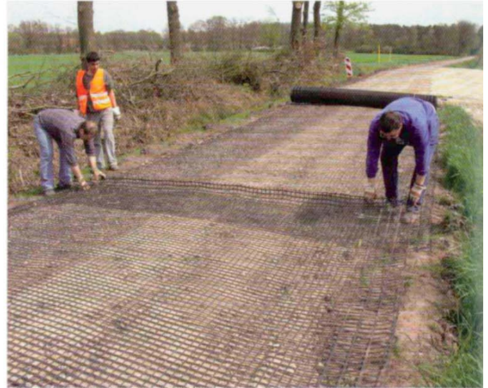
Das Fornit-Geogitter sichert den festen Verbund der Tragschicht und verhindert seitliche Verschiebungen.
