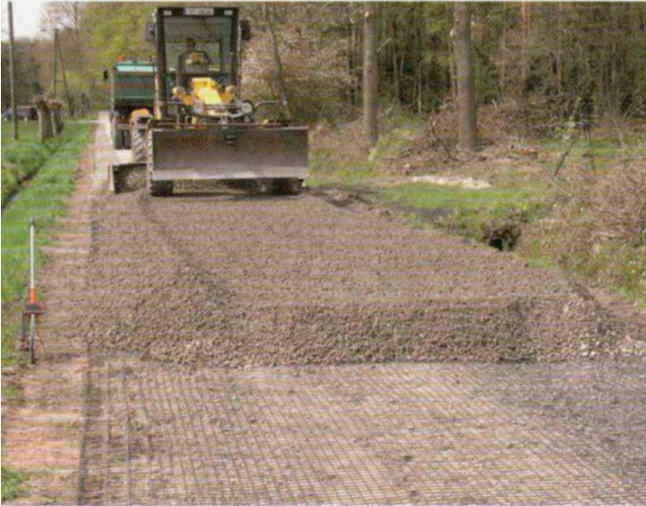
Dehnsteife Fornit-Geogitter verringern die Anforderungen an die Tragfähigkeit der darunter liegenden Böden erheblich.
