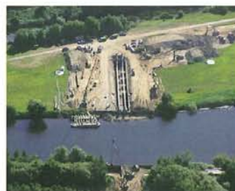
Trinkwasser-Doppeldüker DN 1400 in der Ruhr
