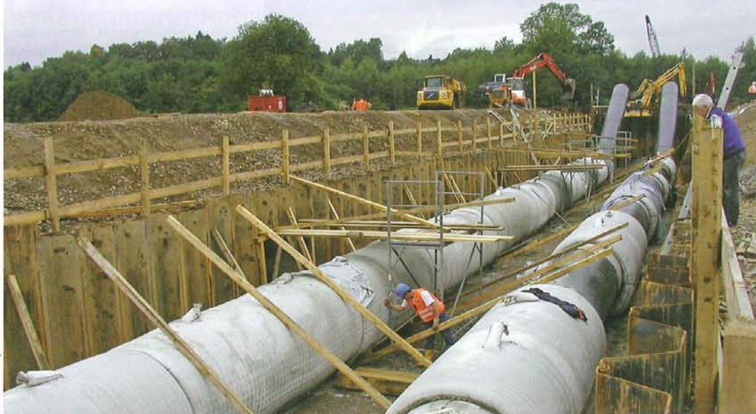
Incomat®-Ummantelung der Rohre im Trockendock
