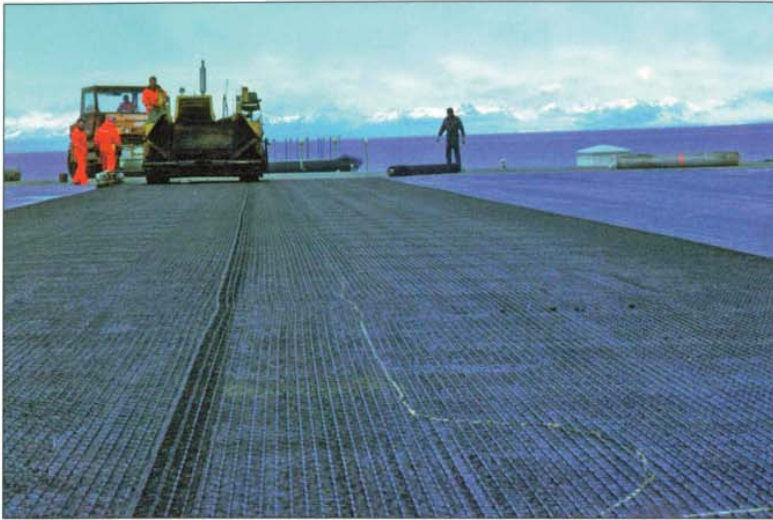
Landebahnsanierung auf Spitzbergen (1989)
