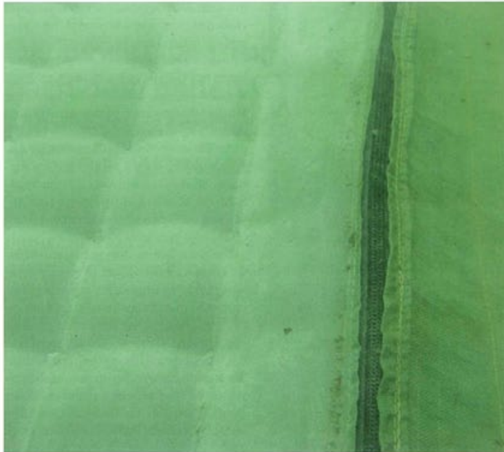
Bild 7: Auskleidung unter Wasser mit Naht (Reißverschluss): links mit und rechts noch ohne Verfüllung
