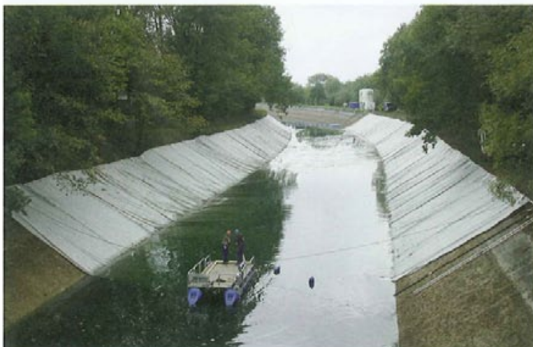
Bild 5: Beginn der Sohlenverfüllung
