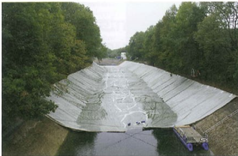
Bild 4: Einbau der Schalungsmatte
