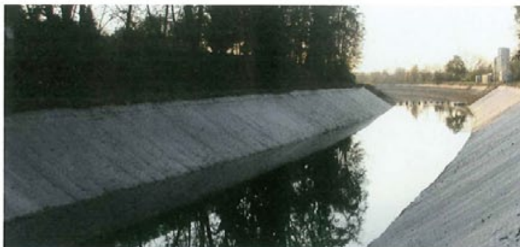
Bild 8: fertig ausgekleideter Kanalabschnitt
