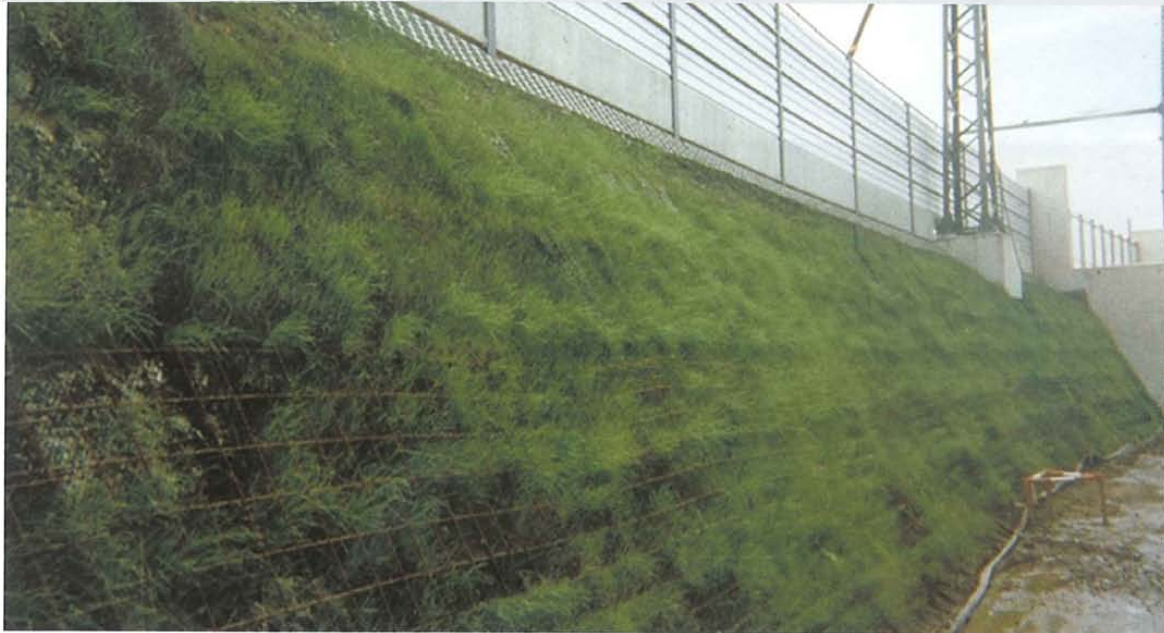
Bild 1: Mithilfe von Geokunststoffen lassen sich Schallschutzwände schön grün und mit steilerem Böschungswinkel auf weniger Platz errichten.
