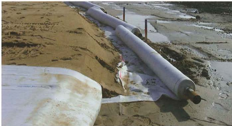
Bild 2: Eine Basisbewehrung aus Geokunststoffen hilft vor allem bei wenig tragfähigen Untergründen.
