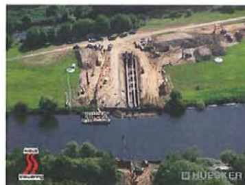
Trinkwasser-Doppeldüker DN 1400 in der Ruhr Foto: Stewering
