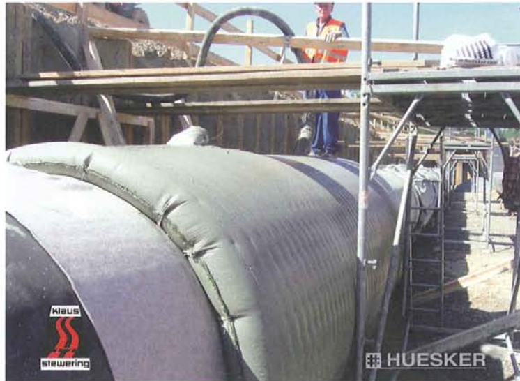
Befüllung eines Incomat-Elements mit Beton
