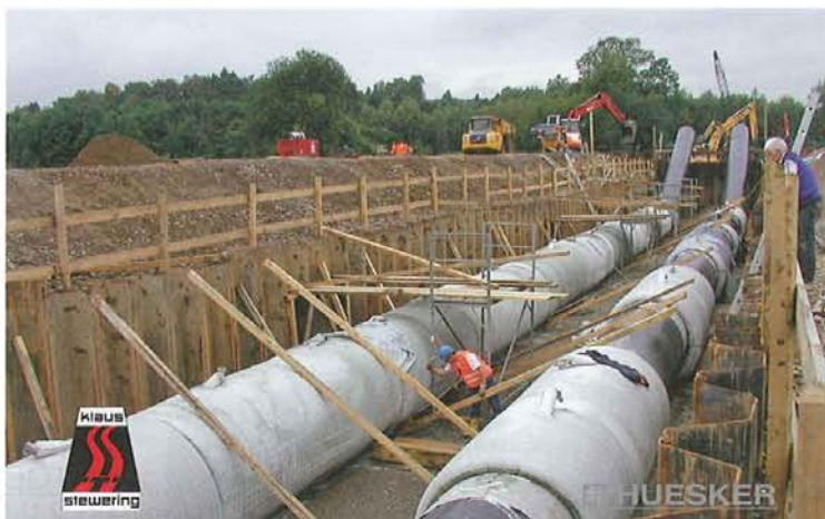
Incomat - Ummantelung der Rohre im Trockendock
