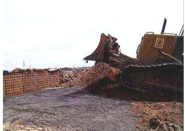
Vor-Kopf-Einbau von Hinterfüllmaterial.
