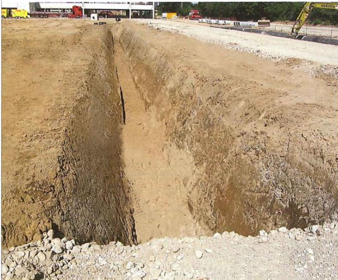
Die vorprofilierte Sickermulde vor Verlegung der Bentonitmatte.
