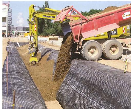
Einbau und Verdichtung der Sickerpackung in der mit Na-Bento abgedichteten Mulde
