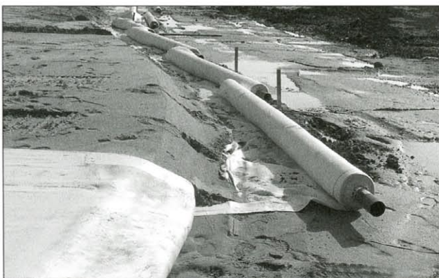
Abbildung 1: Ein Gewebe aus Polyester als Basisbewehrung beim Bau eines Erdwalls auf weichem Untergrund
