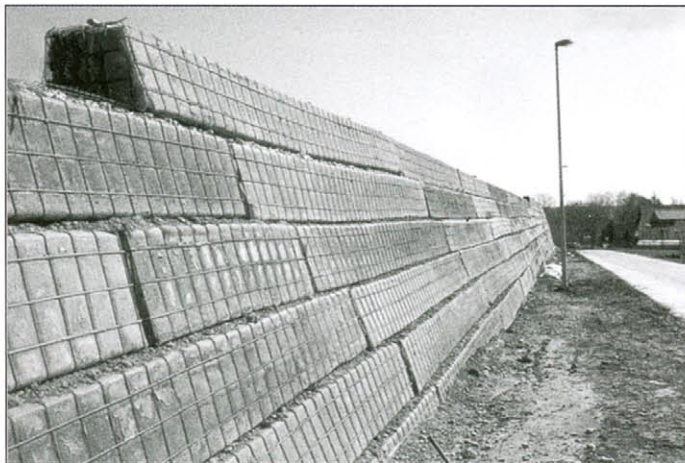
Abbildung 5: Bewehrte Böschung mit Gabionen als Frontelemente
