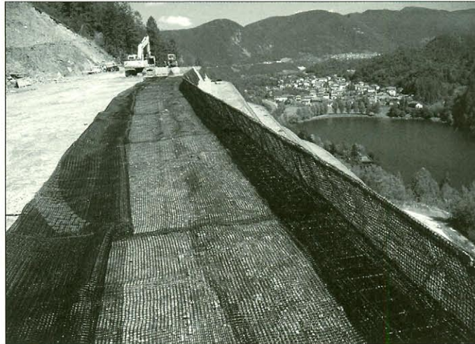
Die flexiblen und hochfesten Bewehrungsgitter werden horizontal positioniert, anschließend wird Schüttboden aufgebracht und verdichtet
