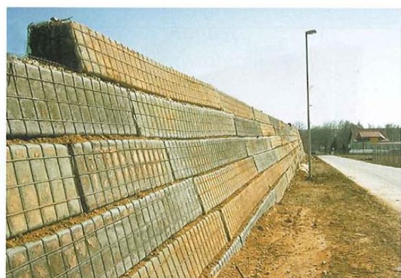
Bild 5: Bewehrte Böschung mit Gabionen als Frontelemente
