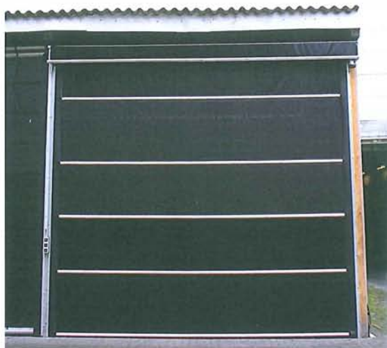
Außenansicht: Original-LUBRATEC® - Rolltor mit Stabilisierungsprofilen
