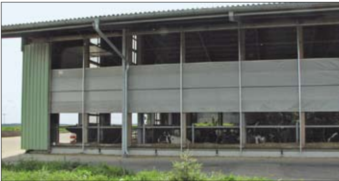
Bild 3: Die Zuluft kann im Liege- und Traufbereich einströmen. Gleichzeitig kann mit der Schattierung dem Aufheizen des Stalles begegnet werden.
