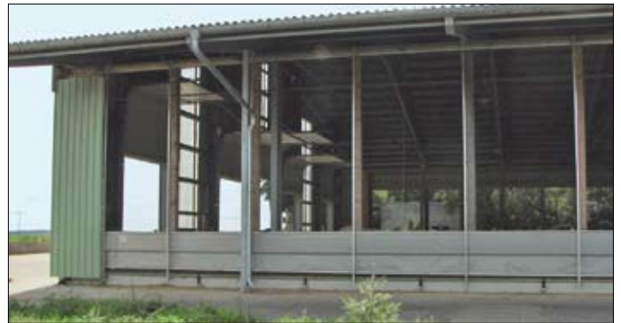
Bild 2: Die Zuluft kann im Traufbereich einströmen.
