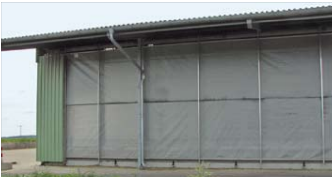
Bild 1: Die Traufseite ist bis auf eine geringe Mindestbelüftung verschlossen.
