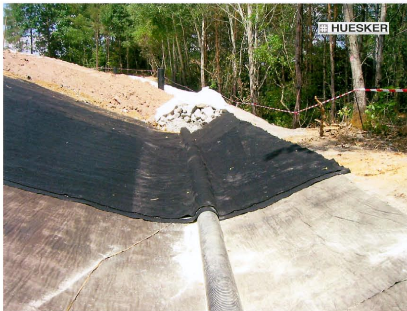
Die Sickerwassermenge der ehemaligen Bauschuttdeponie Goppoltsried sank nach der Rekultivierung mit der doppellagigen GTD NaBento® und der Drainagematte Enkadrain® erheblich
