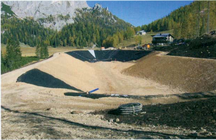
Speicherteich Wurzeralm (Hinterstoder, A): GU: Fa. Bernegger Bau aus Molln, Abdichtung: ISO-M GmbH St. Peter ob Judenburg, HUESKER Geokunststoffe.
