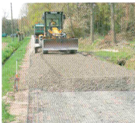
Dehnsteife Fornit®-Geogitter verringern die Anforderungen an die Tragfähigkeit der darunter liegenden Böden erheblich.
