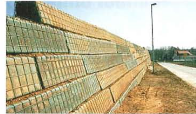
Bewehrte Böschung mit Gabionen als Frontelemente
