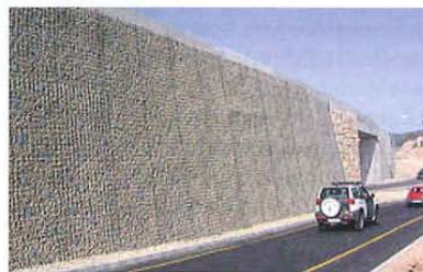
Bewehrte Böschung mit Facingsystem Muralex in Spanien
