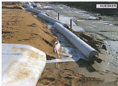
Ein Gewebe aus Polyester (hier: Stablenka 150/45) als Basisbewehrung beim Bau eines Erdwalls auf weichem Untergrund
