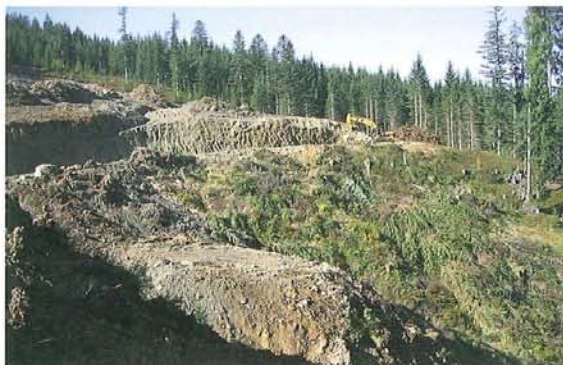
Bild 1. Dammbewehrung mit Fortrac®-Geogitter im schwierigen Gelände – Dammaufstandsfläche stellt hohe Anforderungen an Planer und Bauunternehmen
