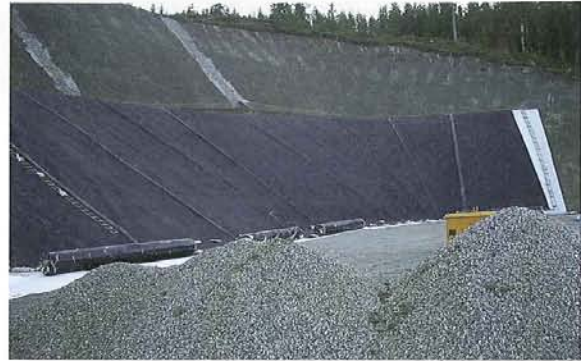
Bild 2. Abdichtungsarbeiten mit HUESKER-Produkten
