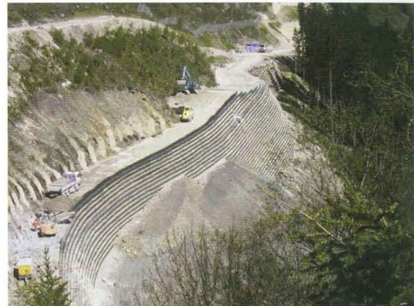
Bis zu 28 m hohe KBE Konstruktion verhindern das Abrutschen des Hanges.
