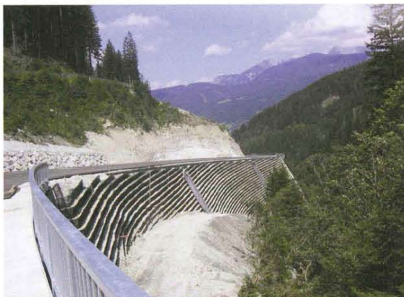
Die serpentinartige Trasse nach der ersten Vegetationsperiode. Fotos: HUESKER
