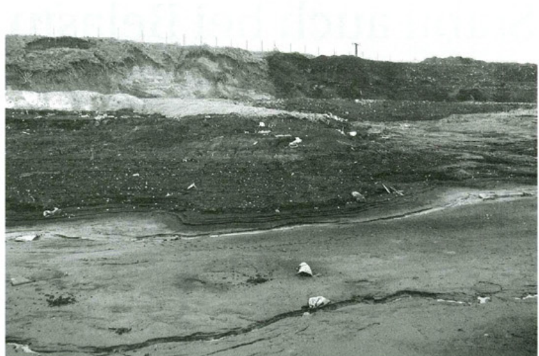
Im südlichen Bereich der Grube Hoffnung reichten bereits im Randbereich außerhalb der Grube Lasten von Baugeräten, um einen Grundbruch in dem weichen Schlamm zu erzeugen
