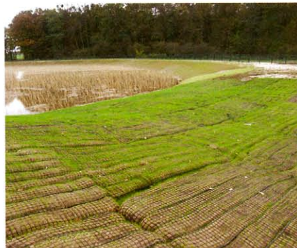
Bild 2. Netzkammerdeckwerk – der innovative vegetative Erosionsschutz
