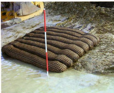
Bild 1. Befülltes Netzkammerdeckwerk mit mehrschichtiger Erosionsschutzmatte u. a. mit HaTe®-Gewebe
