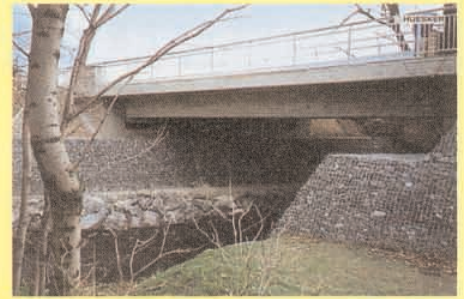
Brücke über die Ilse: Erstes permanent geogitterbewehrtes Brückenwiderlager Deutschlands.
