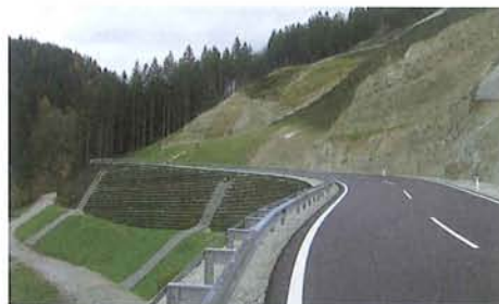
Bild 8. Teilansicht KBE-Böschungen im Bereich der Kehren: oben zur Verkehrs freigabe im Sommer 2008 und unten im Sommer 2011.
