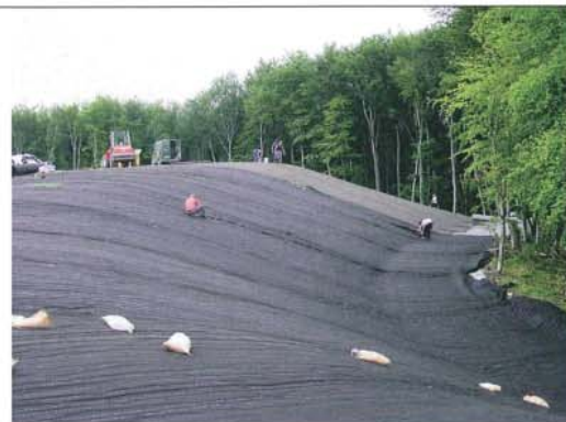
Weil über dem Deponiekörper nur eine Dichtungsbahn verlegt werden muss, spart man Zeit und Kosten.
