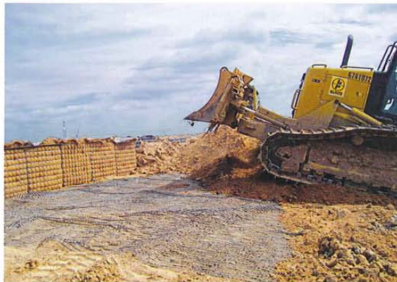
Bild 1. Vor-Kopf-Einbau von Hinterfüllmaterial
