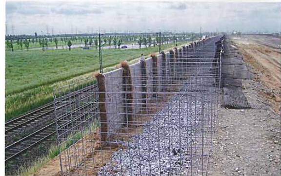
Bild 3. Ungefüllte Gabionenreihe mit Geogitterrückverhängung
