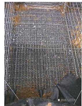
Bild 4. Einbindung der Geogitterbewehrung in den Gabionenkorb (Fotos: HUESKER Synthetic)
